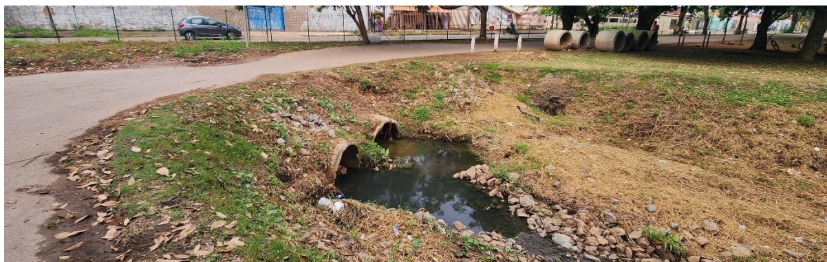
FIGURA 26 - CHEGADA DO CANAL DA PENAL NO PARQUE DAS MANGUEIRAS
