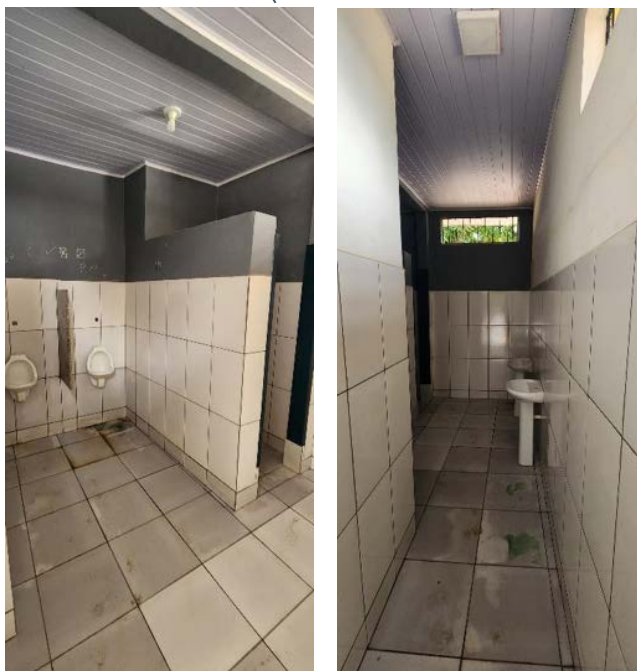
FIGURA 42: BANHEIROS – PARQUE DAS MANGUEIRAS
