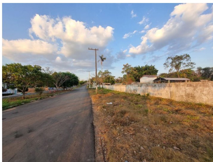
FIGURA 21 - MURO DO CEMITÉRIO SANTO ANTÔNIO
