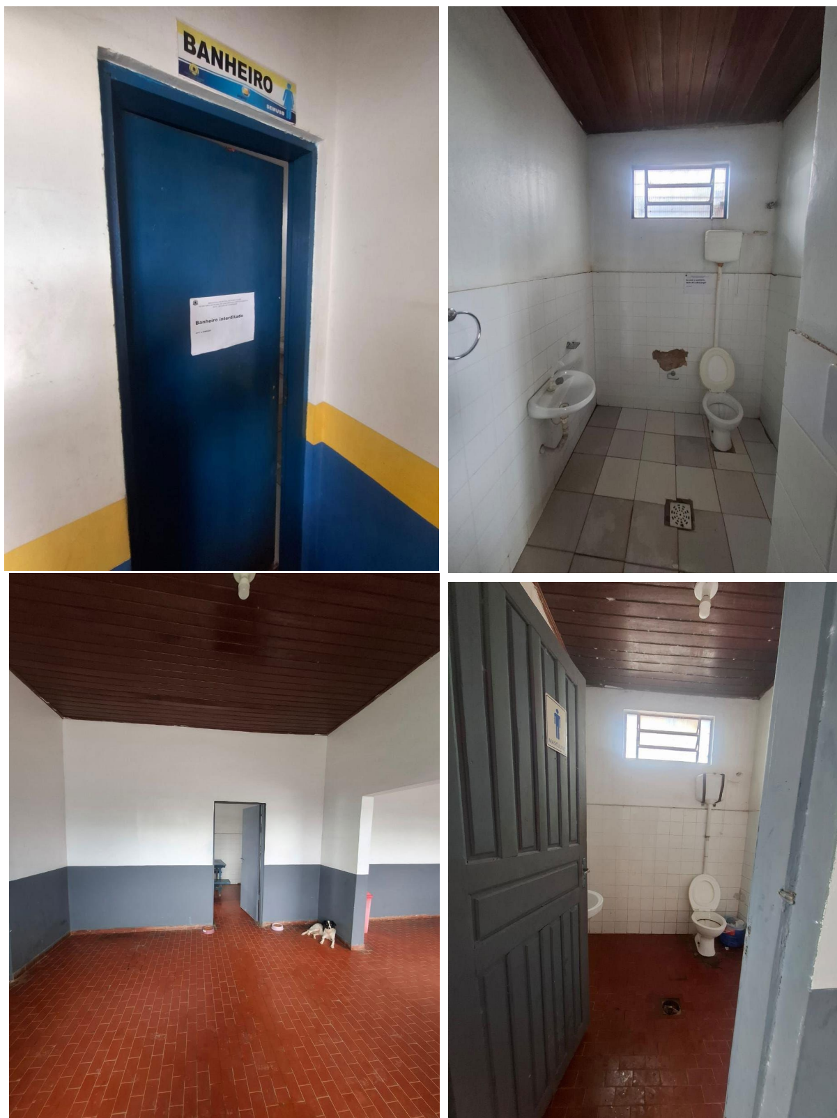
FIGURA 16 - ÁREA INTERNA SETOR ADMINISTRATIVO DO CEMITÉRIO SANTO ANTÔNIO
