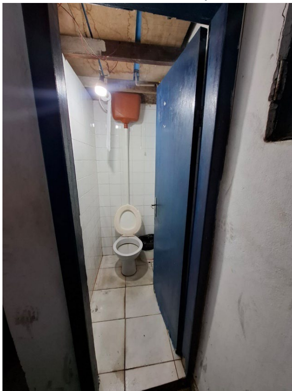
FIGURA 10 - BANHEIRO CAPELA DO CEMITÉRIO JARDIM DOS INOCENTES
