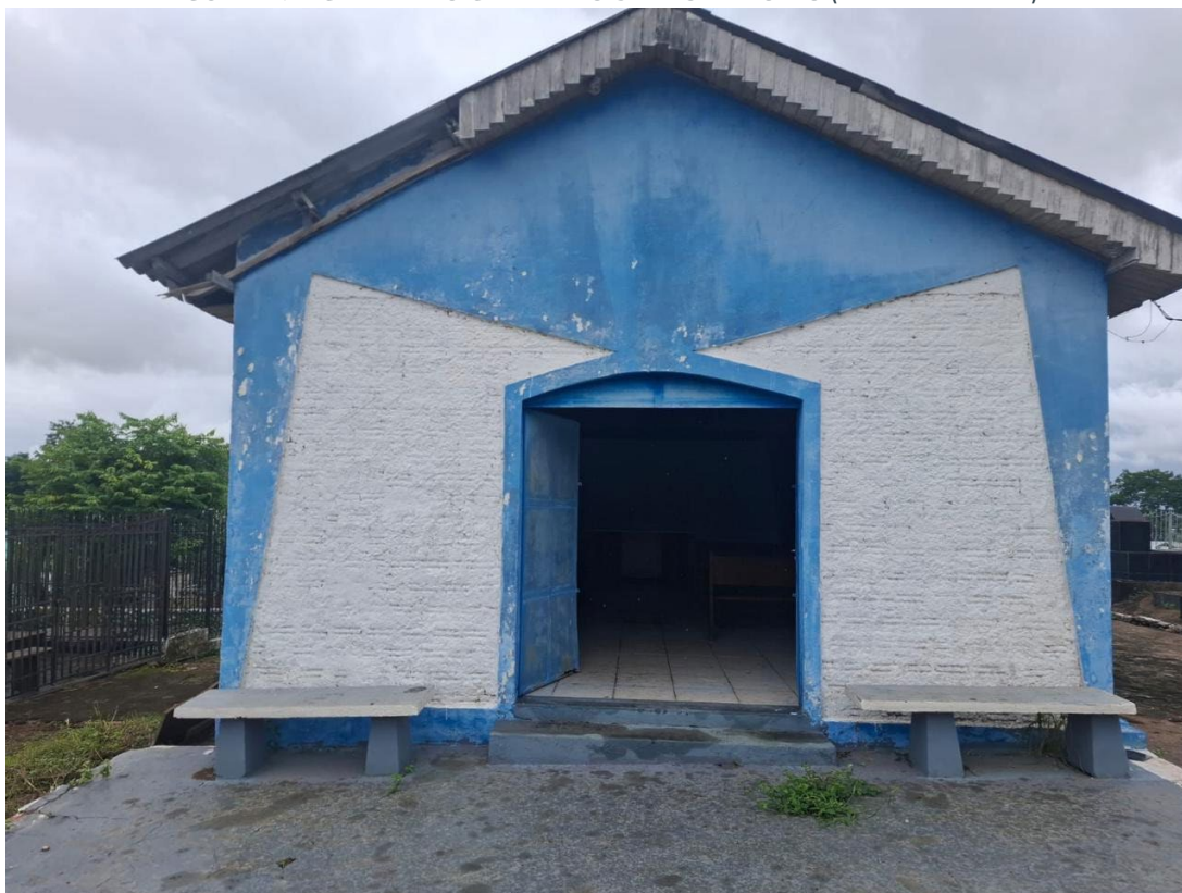
FIGURA 17 - CAPELA DO CEMITÉRIO SANTO ANTÔNIO (ÁREA EXTERNA)
