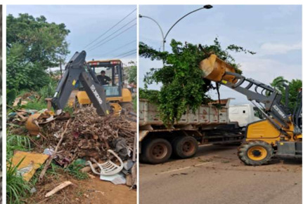
Realização de Erradicações de árvores e limpeza
