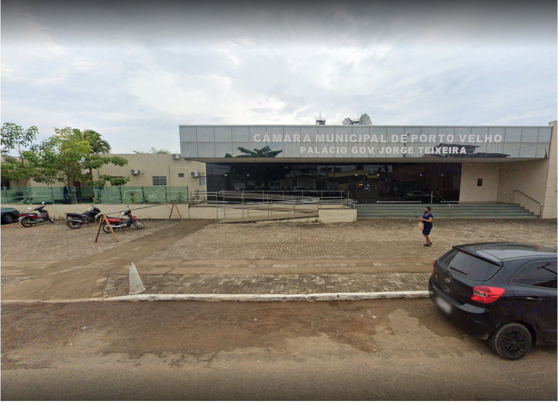
FACHADA DO LOTE PELA RUA BELÉM
