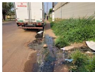
Descarte de água imprópria na rua
