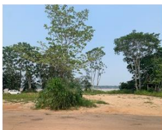
Terraplanagem no Bairro Triângulo
