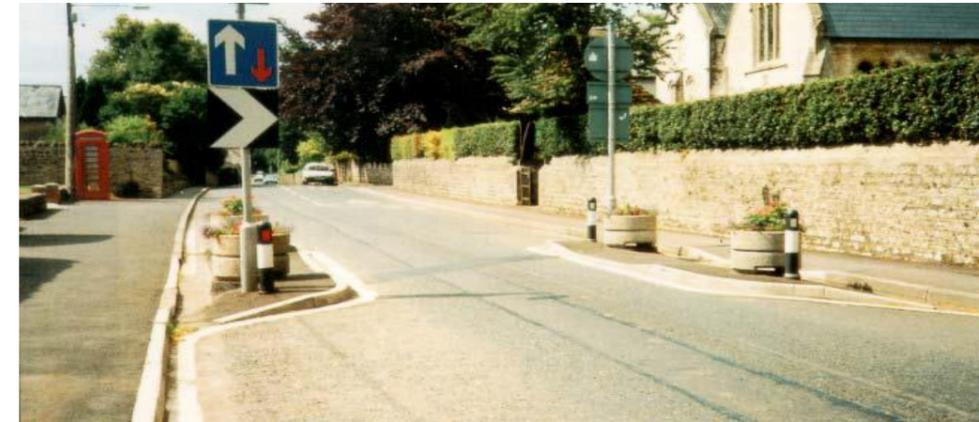
Figura 11: Exemplo de medida de moderação de tráfego, redução da largura da via de modo a permitir a passagem de apenas um veículo.
